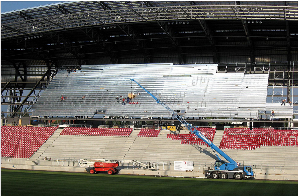
Die Firma Lichtgitter erweiterte das Stadion Klagenfurt mit einer Tribüne.
